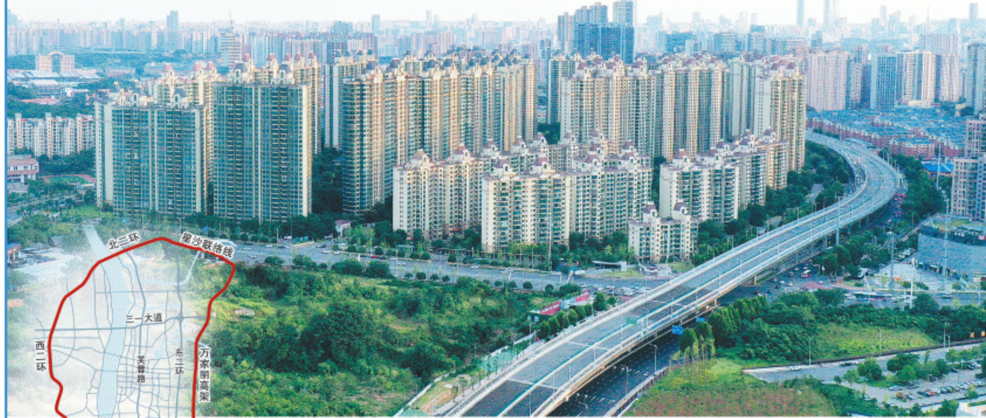
万家丽路快速化改造北延线主线高架桥全长约4.2千米,桥宽25米,设计时速80公里。长沙晚报全媒体记者 王志伟 摄
