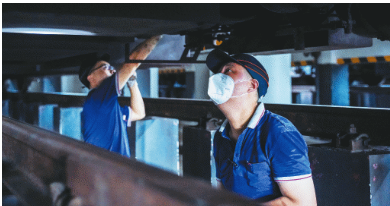
检修人员冒着高温对地铁进行体检。长沙晚报全媒体记者 易亿 摄
