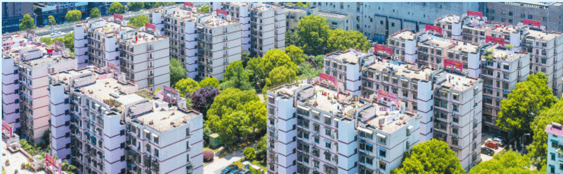
长沙晚报报业小区所有楼栋、单元都加装了电梯,成为全市首个规范化、规模化、整体成片加装电梯的示范小区。均为长沙晚报全媒体记者 邹麟摄
