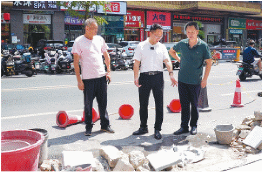
雨花区井湾子街道党工委书记龙峥嵘（中）正在检查迎新路提质微改造项目。 长沙晚报全媒体记者 冯启阳 摄
