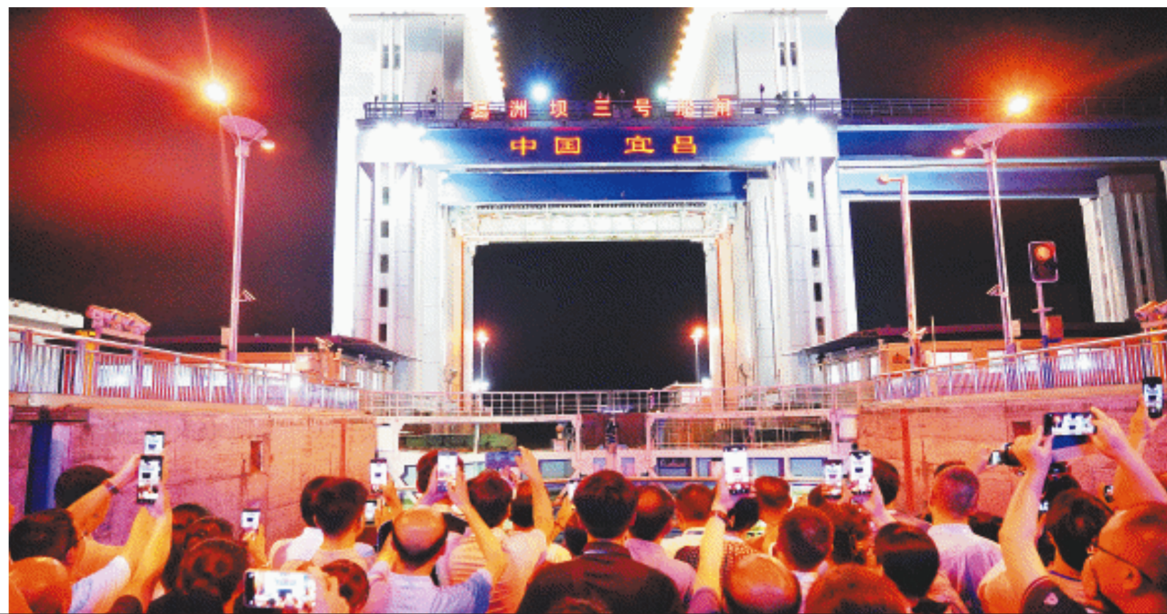
体验葛洲坝船闸“水涨船高”。湖北三峡文旅集团供图
