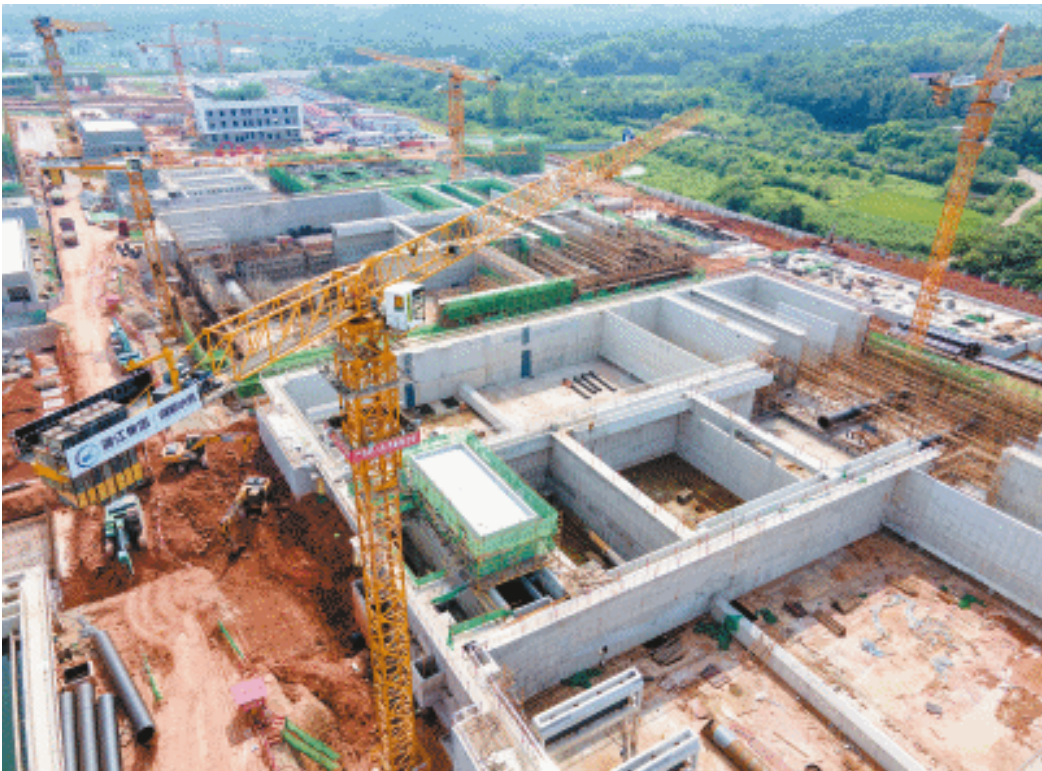
大王山水质净化厂一期项目正在如火如荼地建设中。 长沙晚报通讯员 范龙贵 摄
