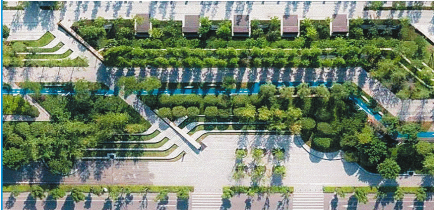
长沙机场改扩建工程景观绿化效果图。中建五局供图
