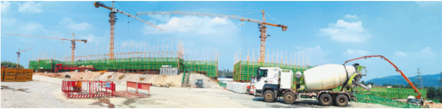
湘华职校灰汤校区项目正在紧锣密鼓地建设推进。张禹摄
