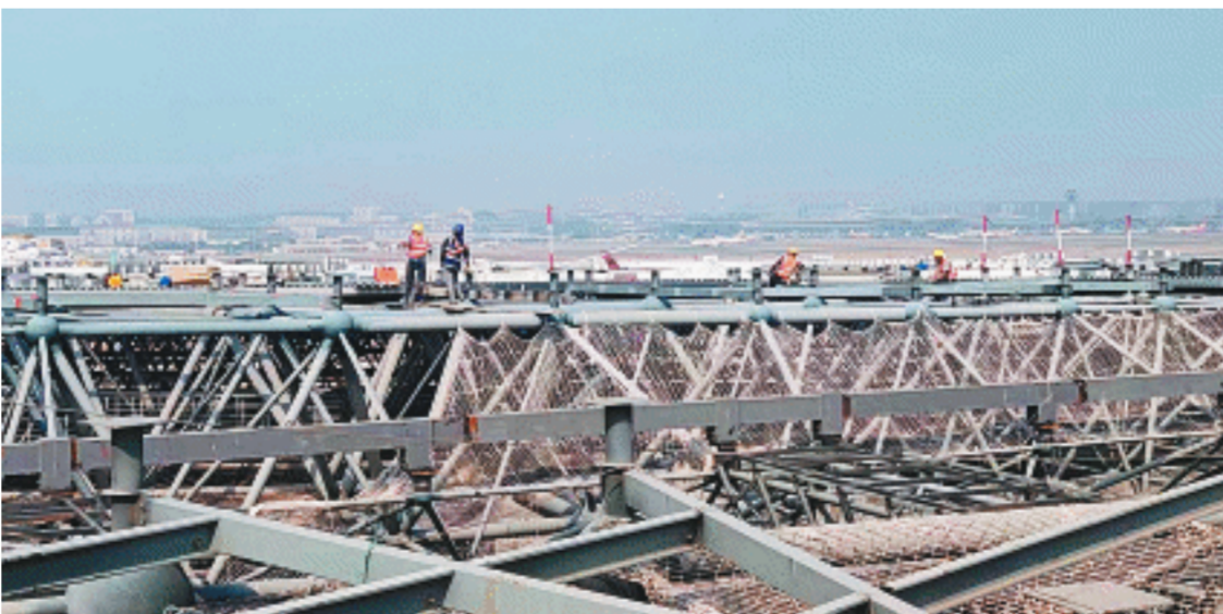
T3航站楼施工现场。中建五局供图
