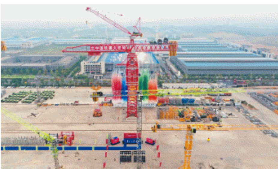
中联重科全球最大22000吨米级超大型塔机首吊成功。受访者供图
