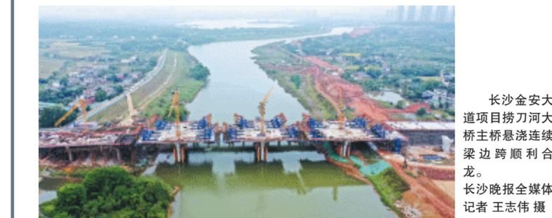
长沙金安大道项目捞刀河大桥主桥悬浇连续梁边跨顺利合龙。长沙晚报全媒体记者 王志伟 摄
