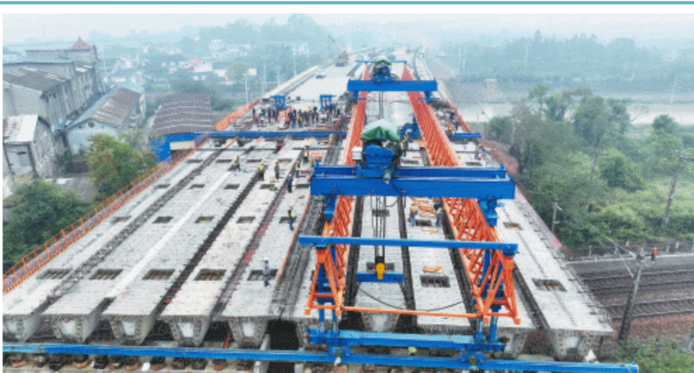
28日，长沙太阳山路震凝跨线桥上跨京广线箱梁架梁工作全部完成。长沙晚报通讯员 贺前军 供图
