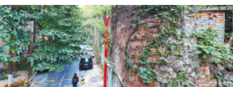
雨花区东塘街道华银园小区垮塌护坡修复完成,居民进出小区安全了。长沙晚报全媒体记者 陈飞 摄
