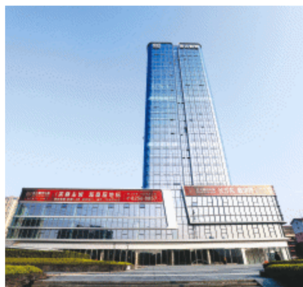
浩天财智中心项目已经竣工验收，即将投入使用。长沙晚报全媒体记者 颜家文 摄
