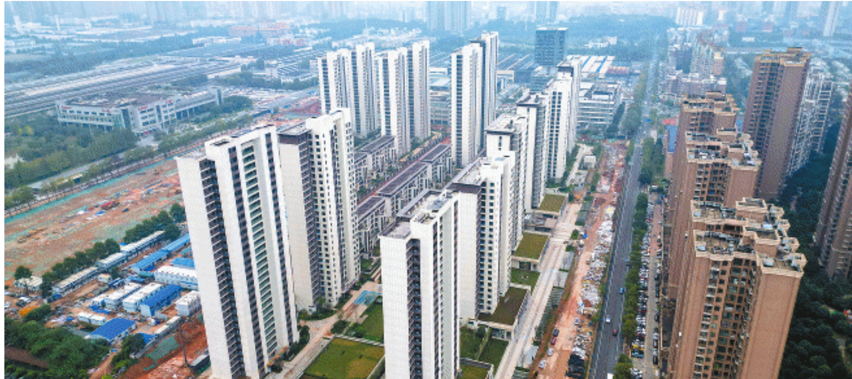
三一云谷项目采用三一筑工柔性智能生产技术建造，实现“空腔搭接后浇、结构安全成本优”，目前已向全国约800个工厂推广应用。易亿 摄
