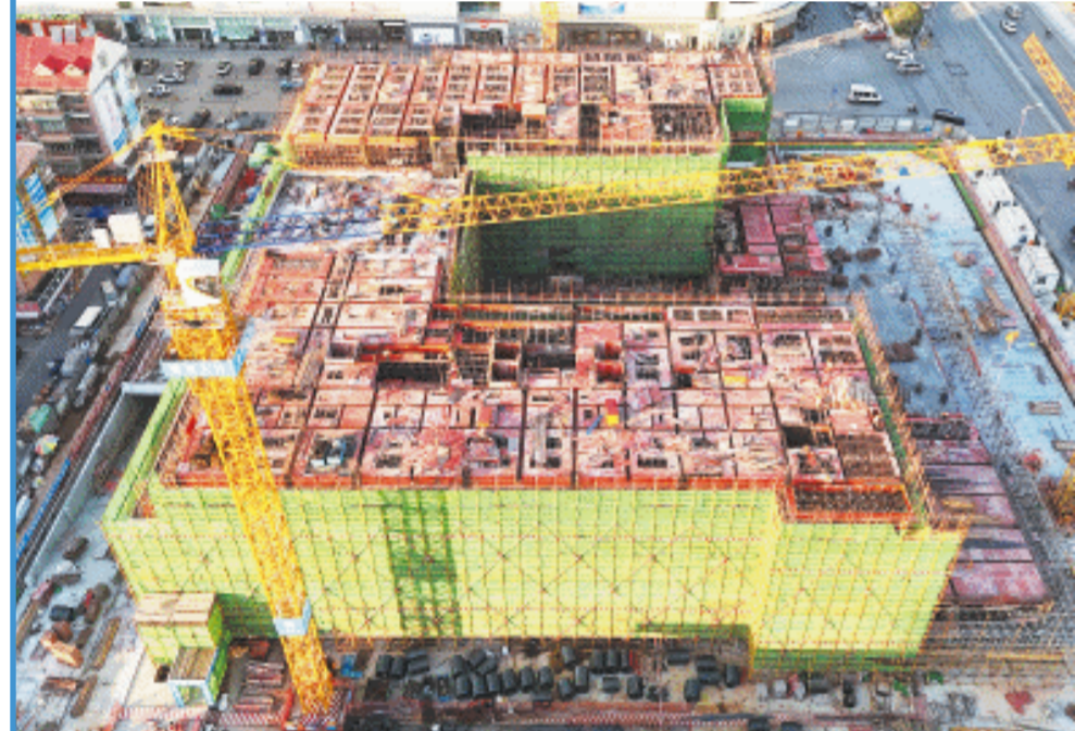
中非经贸总部基地项目进入地上主体施工新阶段。长沙晚报通讯员 马炼 供图
