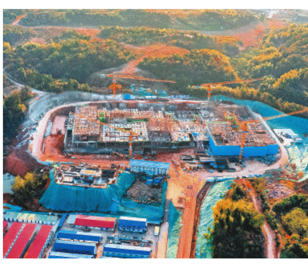
湘江科学中心交易展示中心、科学交流中心、科技服务中心建设场景。长沙晚报通讯员 徐坤 供图
