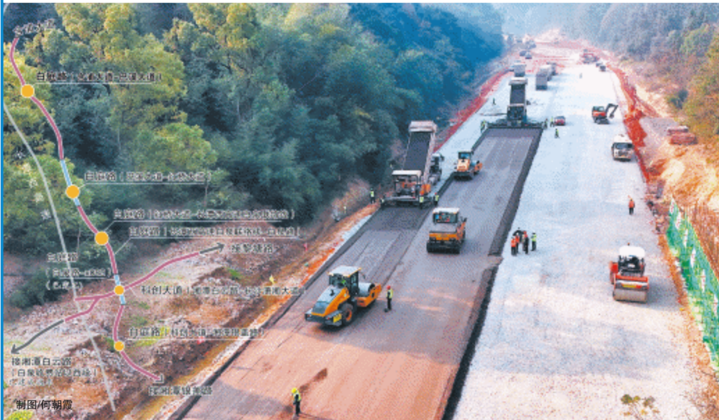
白庭路(科创大道—湘潭银盖路)路正在首层水稳摊铺，标志着该项目迈入路面工程建设新阶段。长沙晚报通讯员 徐坤 供图
