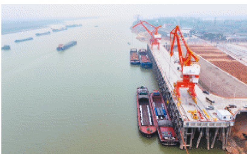
虞公港上游码头2个泊位已试运营，今年12月底4个泊位可投产。均为长沙晚报全媒体记者 黄启晴 摄
