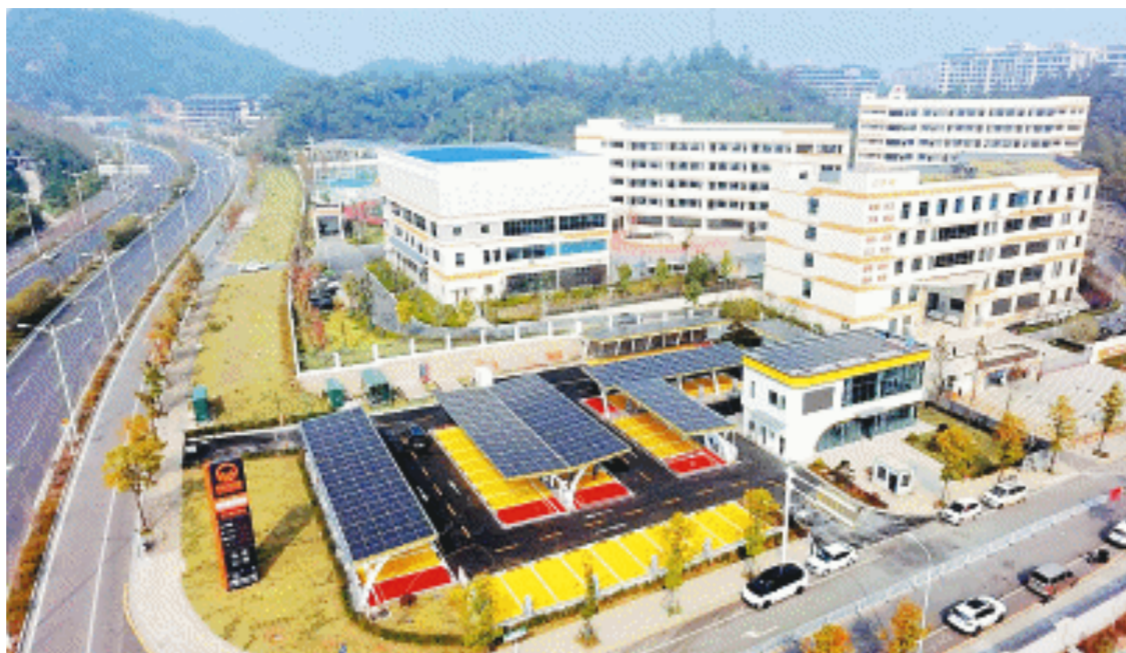
12月26日,麓山控股长望路综合能源站开业,集光伏、储能、超级充电、V2G技术及换电服务于一体。
