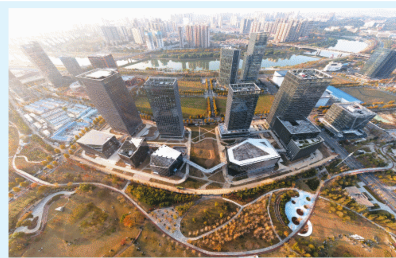
由中建五局总承包公司承建的中南传媒马栏山园区项目竣工,将为湖南出版高质量发展提供强劲引擎。 长沙晚报通讯员 任明敏 供图
